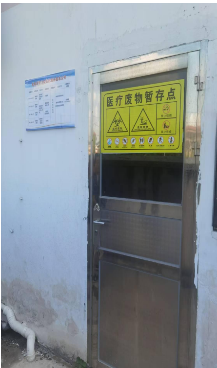
医疗废物暂存间
