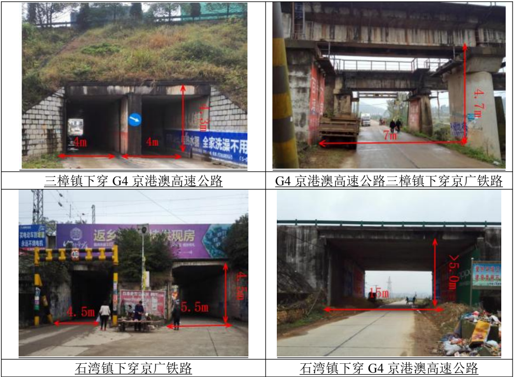
图 2-1 现有工程道路路面情况图
